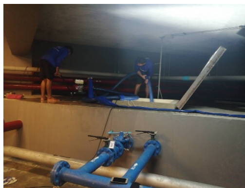
การล้างถังเก็บน้ำ ครั้งล่าสุด
